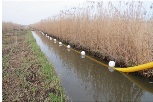
Abb. 18: Schwimmende Drainage an einem Biberdamm.
